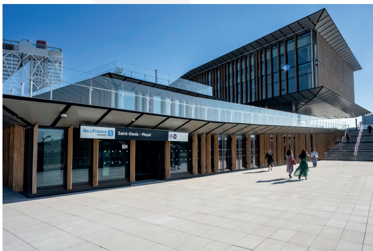
© Kengo Kuma & Associates / Éric Garault / Société des grands projets
